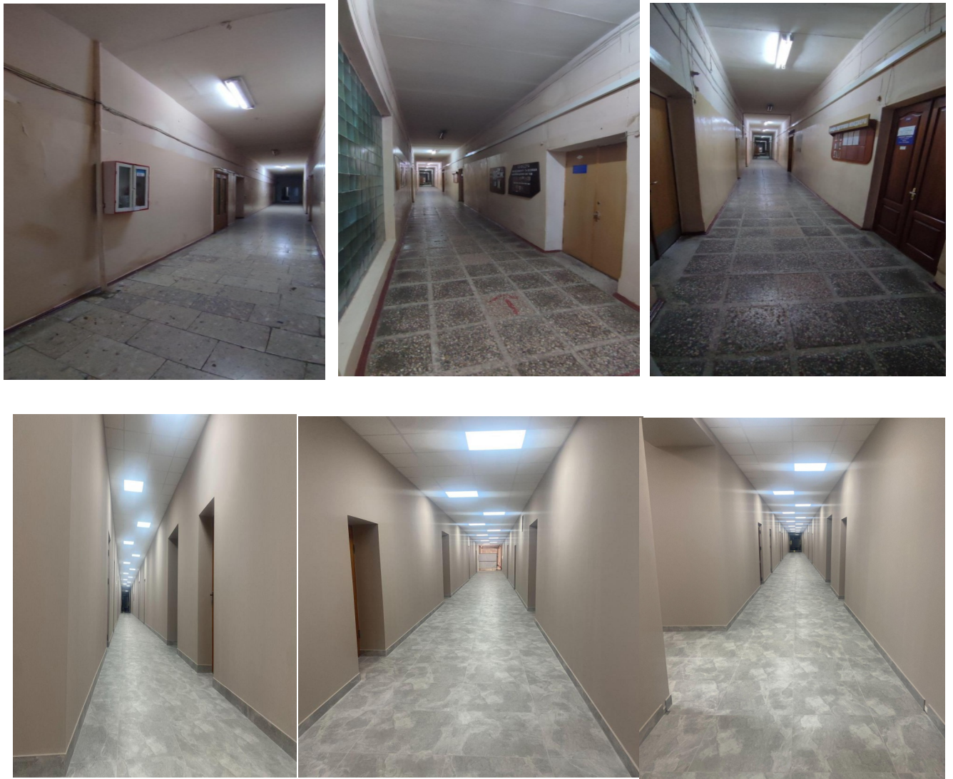
Рисунок 10.1 – Капітальний ремонт коридору першого поверху навчального корпусу №2
