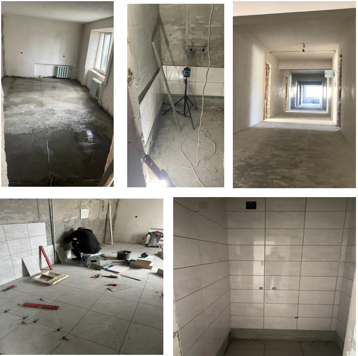
Рисунок 10.3 – Процес виконання ремонтних робіт 5 поверху гуртожитку №3
