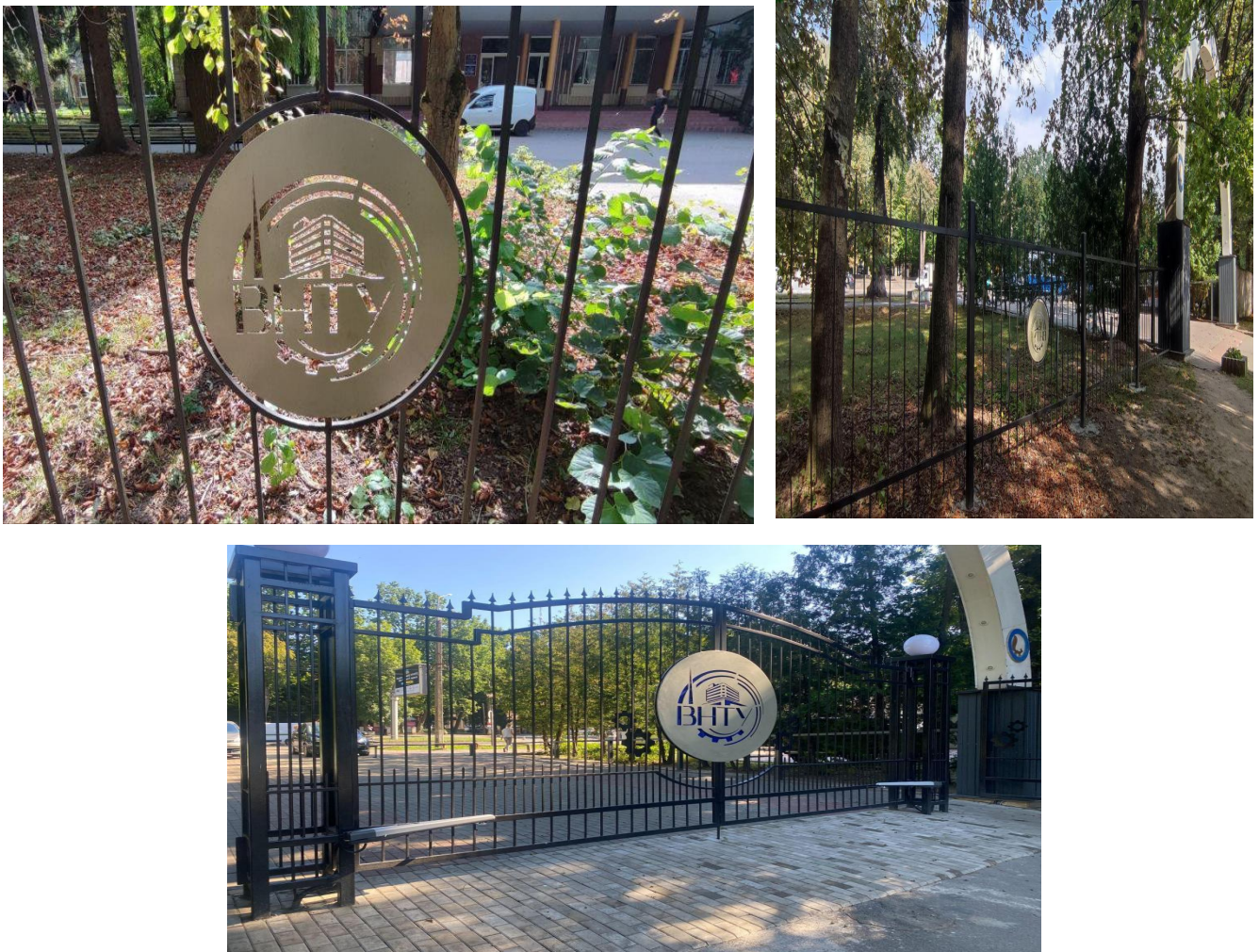
Рисунок 10.4 – Монтаж металевого паркану
