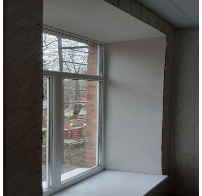
Рисунок 10.5 – Виконання ремонту стін, стель, укосів
